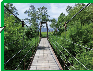
ヨッピー吊り橋
